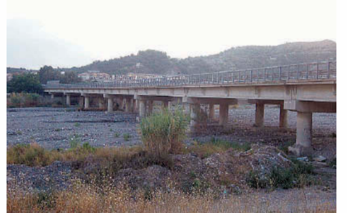
Il ponte sul Nisi che sarà trasformato in pista ciclabile
