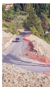
I lavori su via Crocifisso
