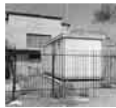
L'IMPIANTO DI SOLLEVAMENTO
