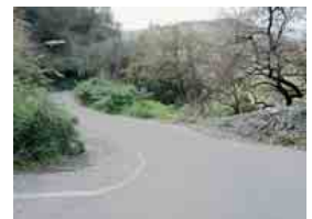
IL TRATTO IN CUI DOVREBBE INIZIARE I LAVORI
