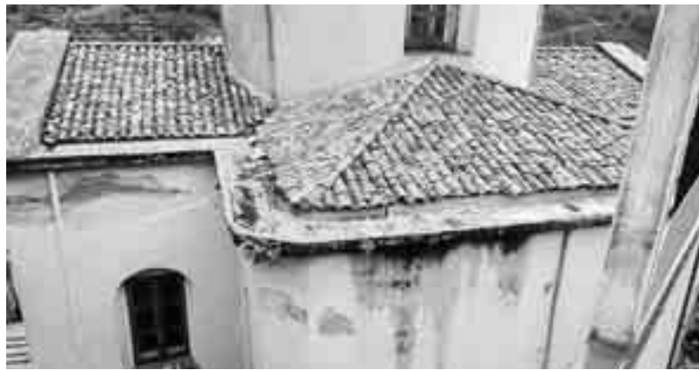
Le tegole della chiesa di S. Pietro frantumate dalla grandine a Fiumedinisi
