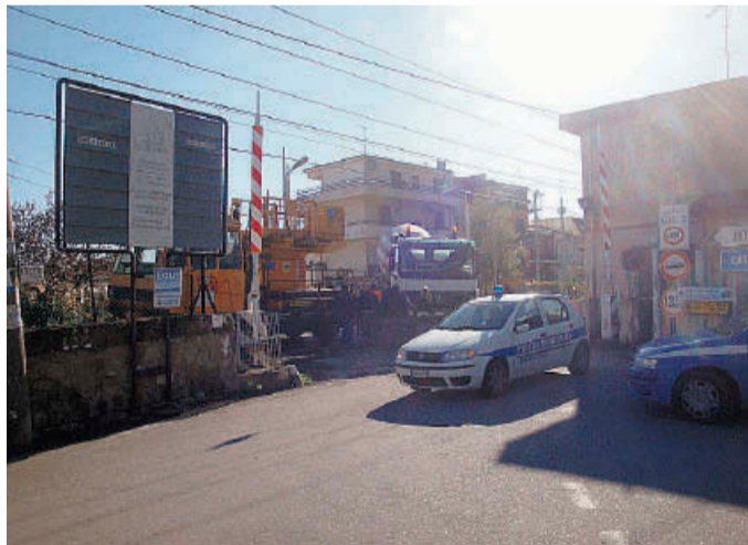
La betoniera rimasta bloccata sulla linea ferroviaria
